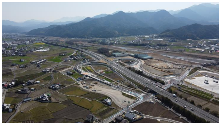
東温スマートインターチェンジ完成写真
