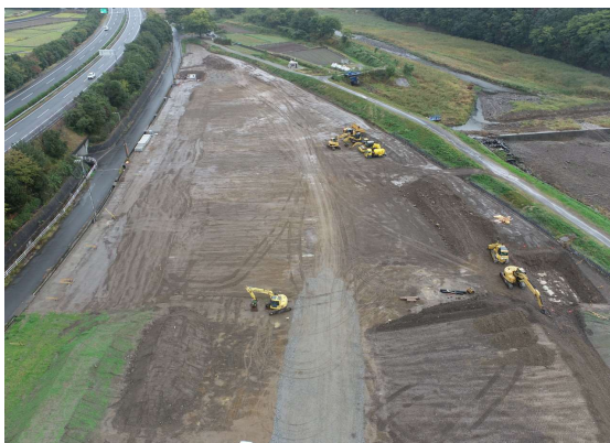
【造成工事中の写真】
