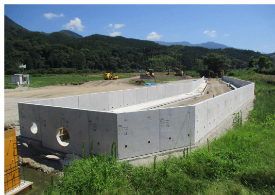
【雨水調整池工事中の写真】
