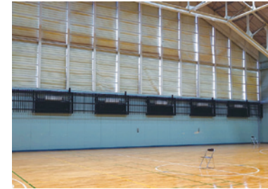
エアコンの設置
