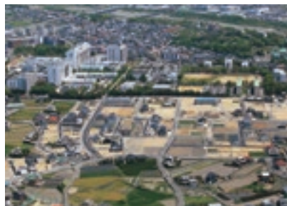
志津川地区土地区画整理事業(23.1h)と道路や公園などの周辺整備を進めています。
