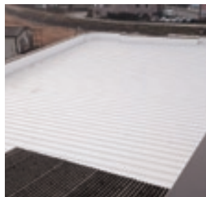
建築物の気温上昇を押さえることを目的に、ホールの屋根に遮熱塗料を塗装しました。
