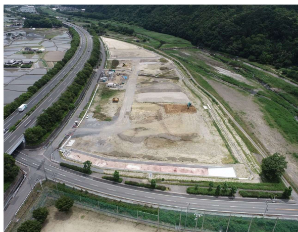
【造成工事中の写真(西から東)】
