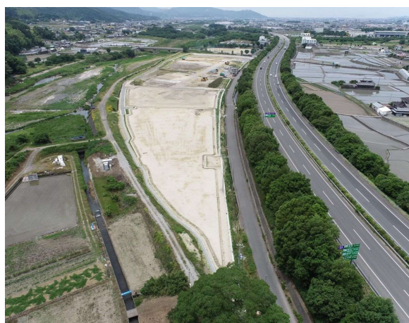
【造成工事中の写真(東から西)】
