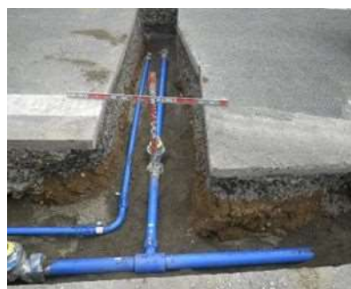
【管路更新工事(アセットマネジメント事業)】
