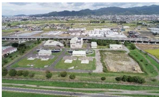
【重信浄化センター】
