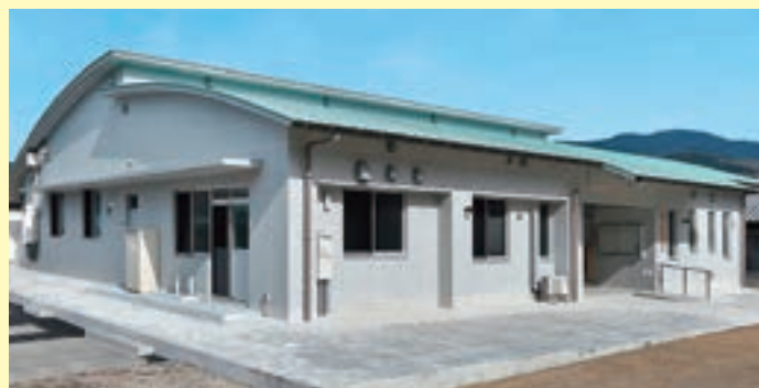
完成した横河原集会所
