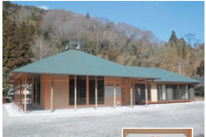
完成した山之内集会所
