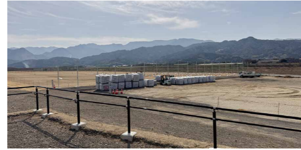
天然芝工事が進むサッカーグラウンド
