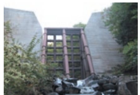
根無谷第2号堰堤（平成20年度完成）
