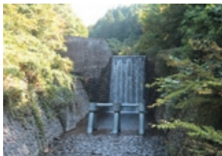
惣田谷堰堤（平成13年度完成）
