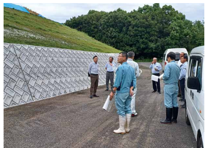
改修工事のため池の視察（西岡）
