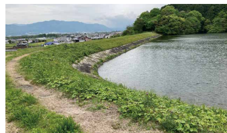
改修予定の上村源平谷池
