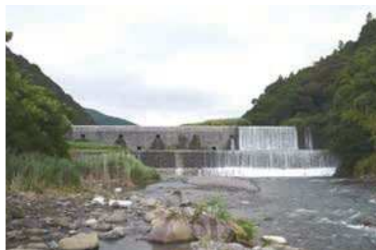
写真3-84 重信川の堰堤(除ヶの堰堤)
