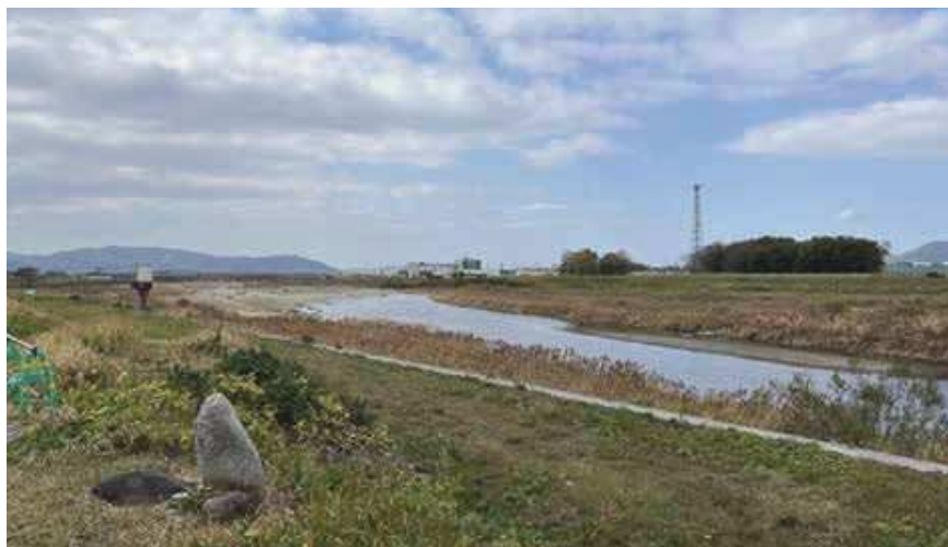
写真3－85 重信川(表川合流地点下流)
