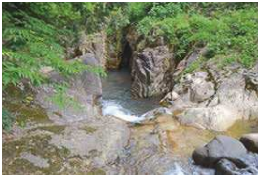
写真3-68 水流により侵食を受けた安山岩
