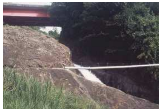
写真3-74 お樋掛けの様子(平成3年撮影)
