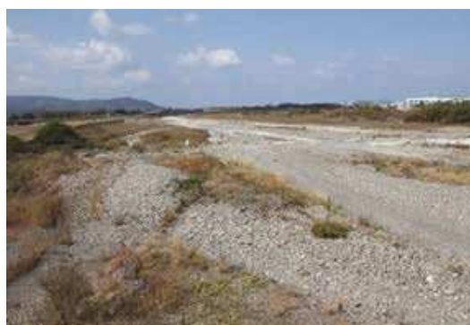
写真1-4 重信川の「瀬切れ」 ( 上村大橋より下流を望む 2023.10.27 )
