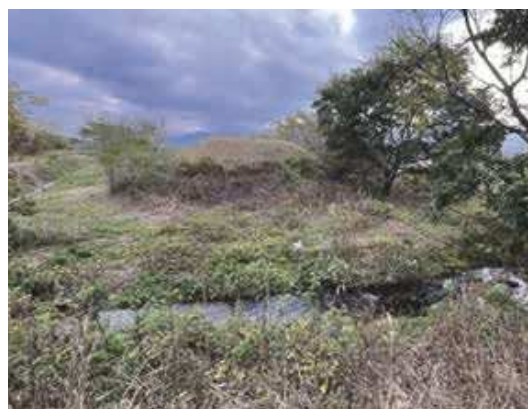
写真3-97 本堤(下流より)
