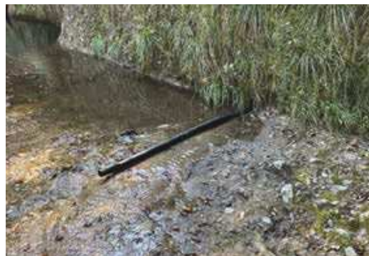
写真3-20 蓑淵の取水ホース
