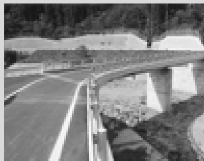
見間屋中間屋線建設工事 総事業費 46,300千円
