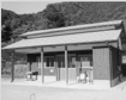
滑川ゲートボール場休憩所建設工事 総事業費 4,560千円
