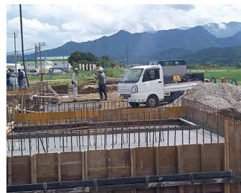
交流拠点施設の建設工事
