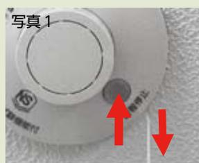
写真1 動作確認: ひもを引くかボタンを押す
