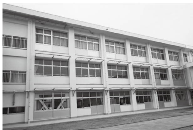
小学校耐震改修工事（南吉井小学校）
