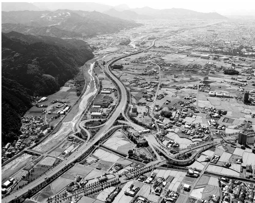
川内インターチェンジ周辺
