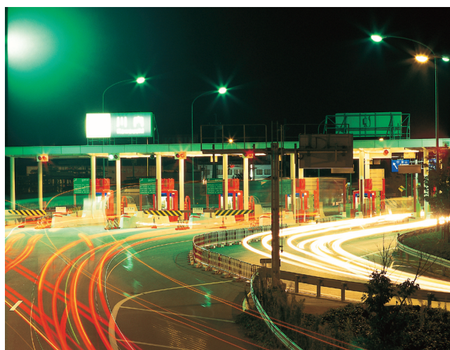
■川内インターチェンジ
