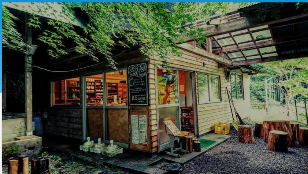
改修後の滑川清流ハウス
