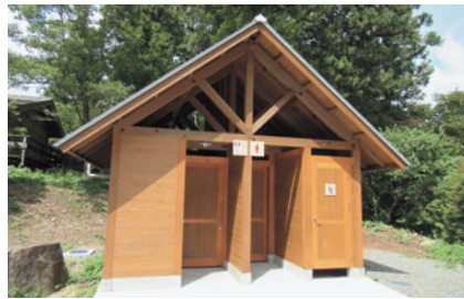
7月に改修した光の森トイレ（風穴付近）
