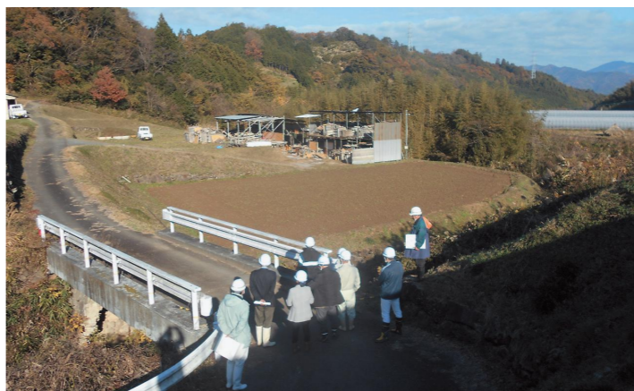
災害復旧工事現場の視察（上林）
