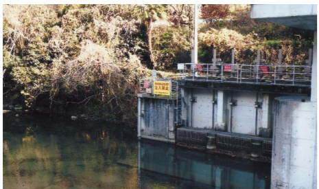
注意喚起を行っている改良区施設
