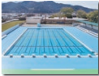
▲新しくなった 川上小学校プール
