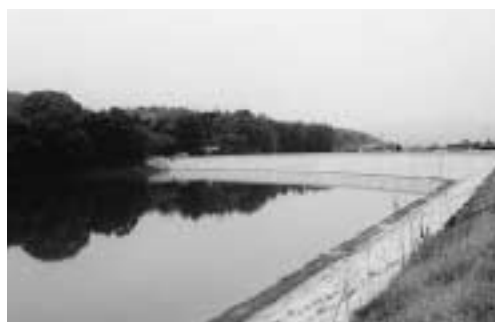
県営ため池等整備事業(上村船川池) 総事業費200,100千円
