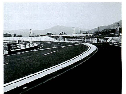
完成した町道天神西組線
