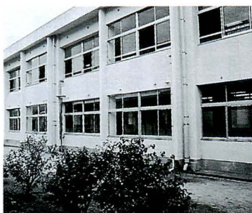
トイレ改修予定の川上小学校
