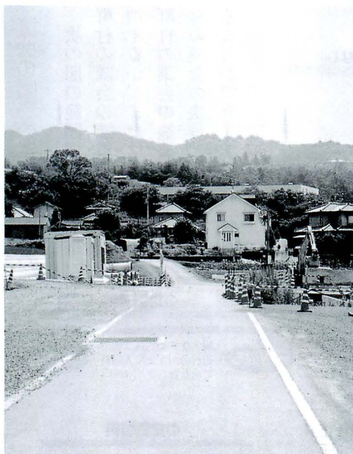
道路改良が進む天神西組線
