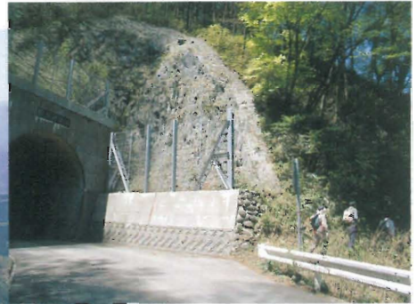
▲井内峠隧道手前の 登山道に入る。
