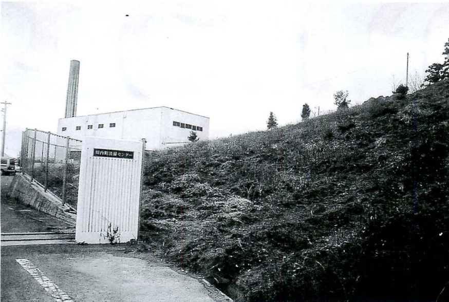
▲ストックヤード（回収したビン類、ペットボトル類の保管施設）の建設が予定されている清掃センター隣接地
