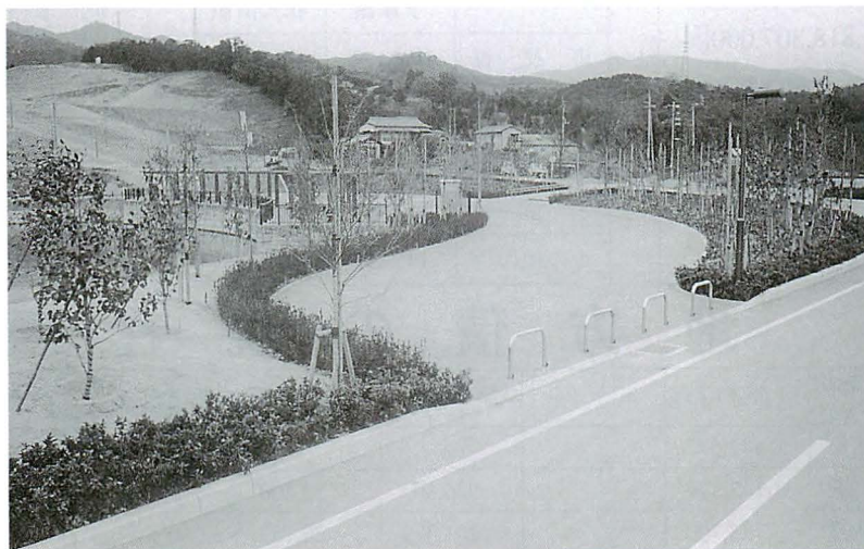
重信町総合公園整備事業 総事業費 147,720千円 (内簡易保険積立金還元融資額 65,000千円)
