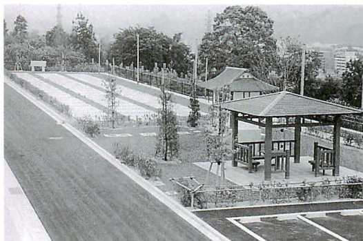
志津川墓園拡張工事 総事業費 425,819千円
