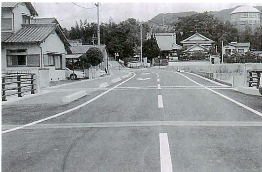
重信町総合公園進入路改良工事 総事業費 190,564千円
