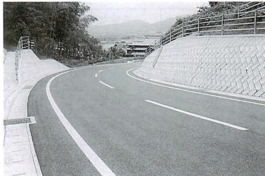
別府佐川線道路改良工事 総事業費 53,307千円
