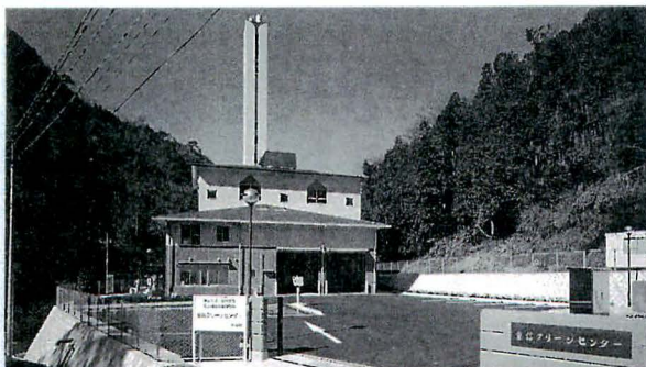
まずはごみの減量を！ 処理は設備の整った施設で行いましょう。
