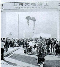
▲上村大橋竣工(H2)
