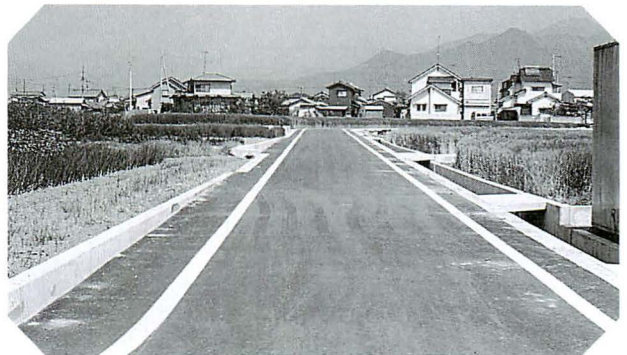
南野田白石出作線集落道路改良工事
