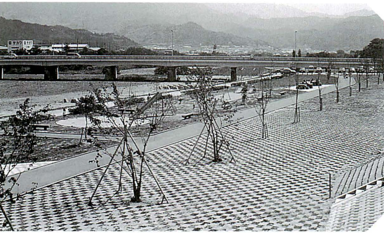
樋口公園整備工事
