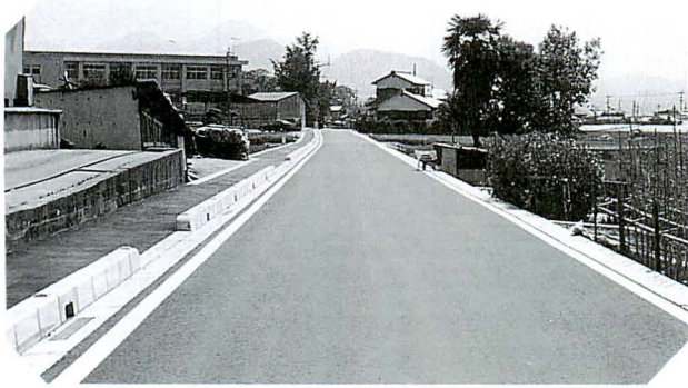
滝沢牛渕駅線道路改良工事
