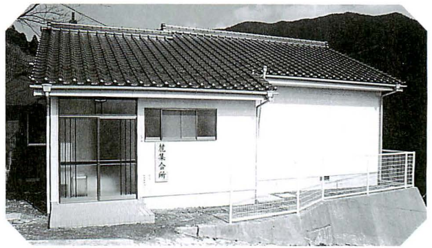
麓集会所新築工事(山之内)
