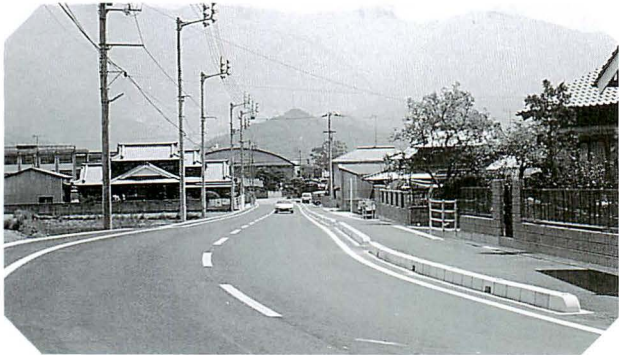
志津川伽呂線道路改良工事
