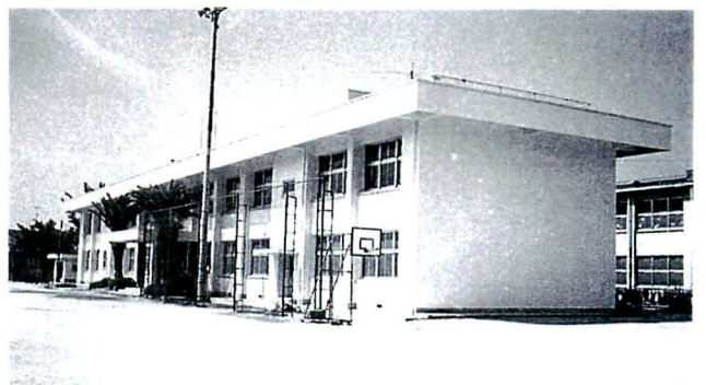
南吉井小学校大規模改造工事
