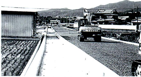
志津川伽呂線道路改良工事
