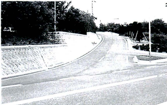
町道西岡演習場線道路改良事業
