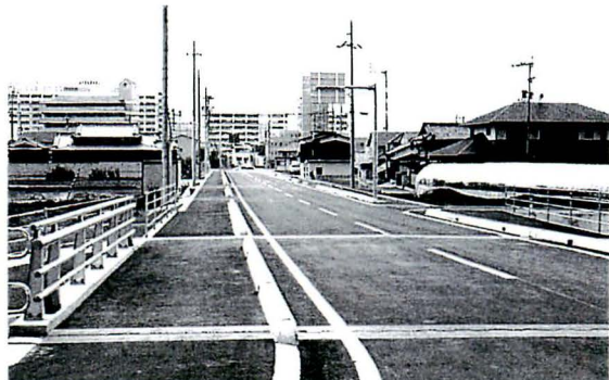
町道菖蒲片山線道路改良事業
