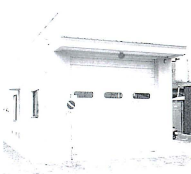
南野田ポンプ蔵置所建設事業
