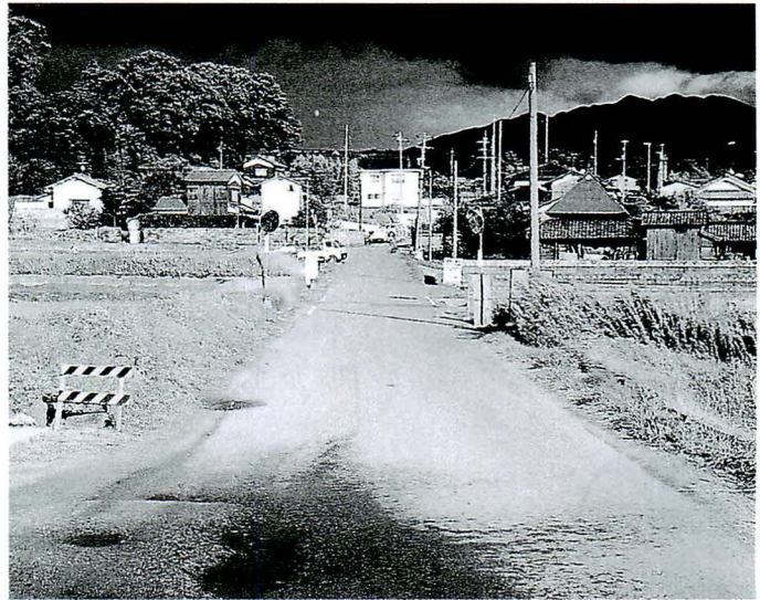
改良が進む 町道西中村西組線
