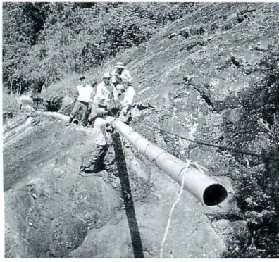
危険な作業のお樋掛け
