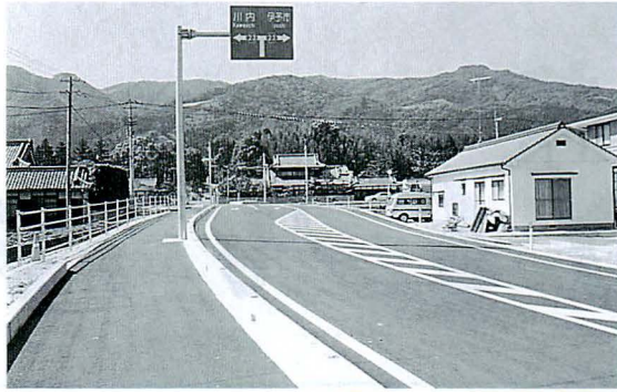
町道牛淵上村線道路改良事業
