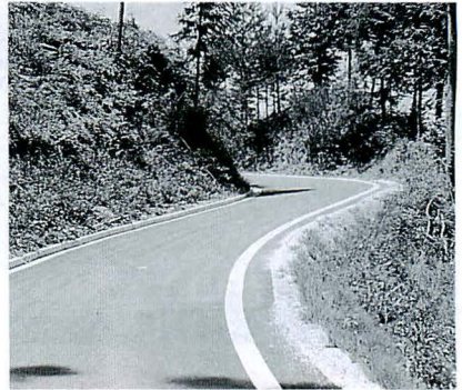
花山鳥越線林道舗装新設事業
