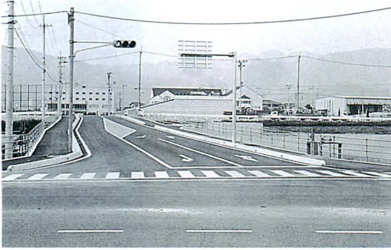
町道平松上極線道路改良事業
