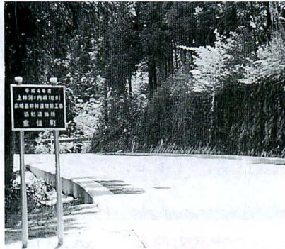
上林河之内線舗装新設事業
