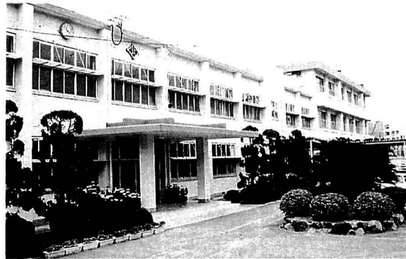
新装なった北吉井小学校
