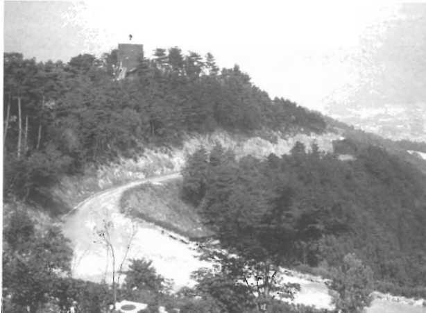
総延長2km余りに及ぶ園内道路の舗装が行われる塩ヶ森
