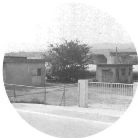
改良工事が行われる川上地区第3水源地
