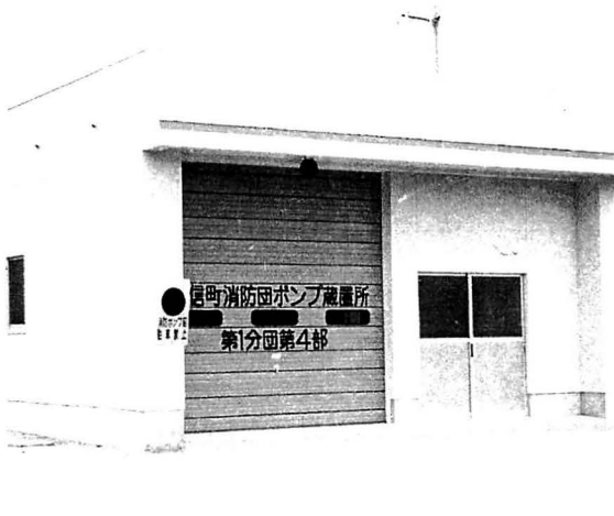
西岡ポンプ蔵置所建設事業
