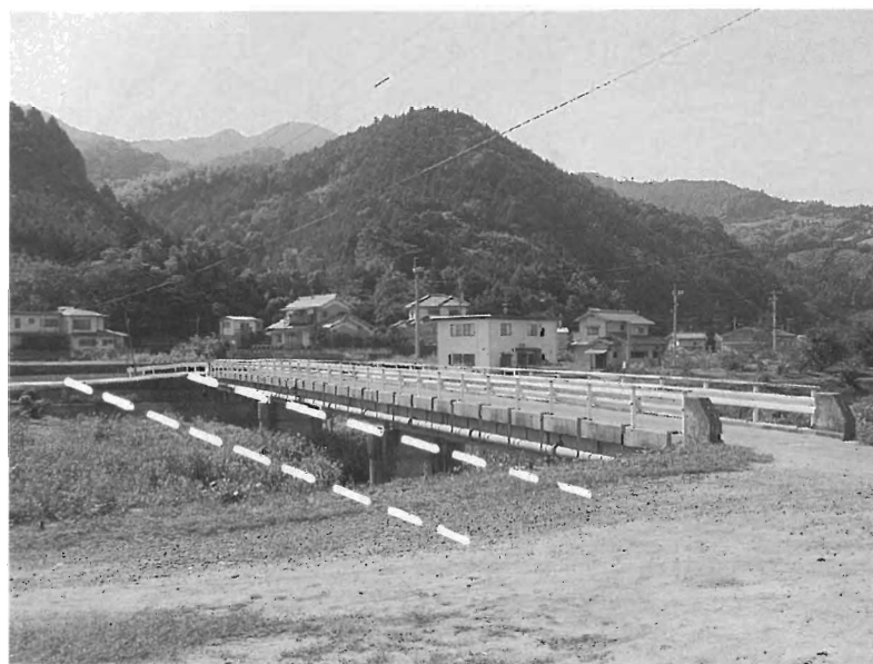
新しく自動車専用橋（幅員5m）が建設される向井川橋 今までの橋は、自転車・歩行者専用橋となる
