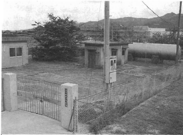
川上地区簡易水道第3水源
