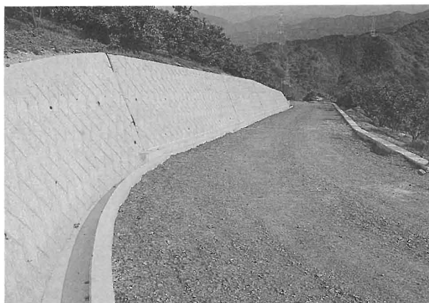
保免農道改良工事
