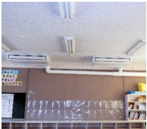
小学校に設置された空調設備
