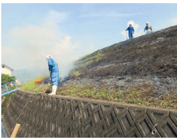
ため池の土手焼(土手強化)の様子
