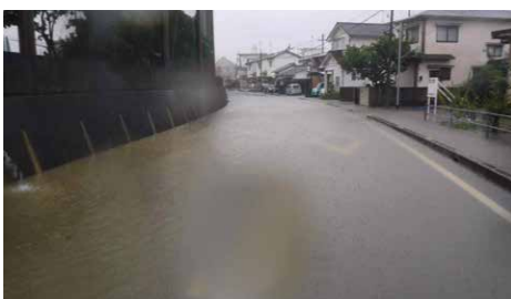
豪雨による浸水状況(東温高校南側道路)
