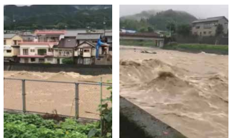
令和元年7月豪雨時の当該地点の様子
