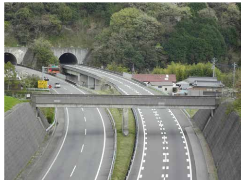
松山自動車道に架かる農道橋
