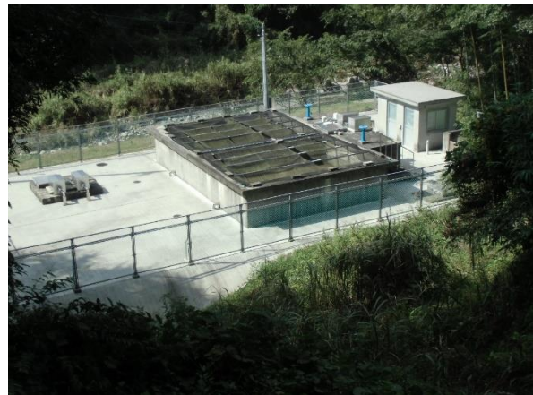
松瀬川浄水場 全景
