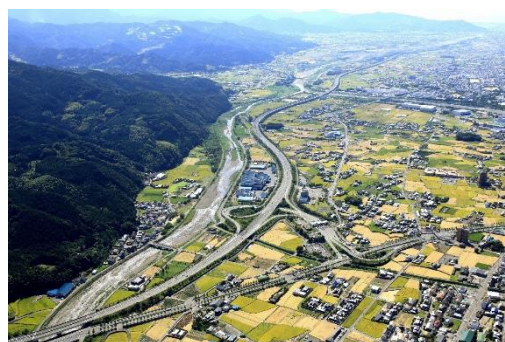
川内インターチェンジ
