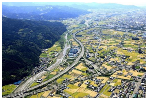
川内インターチェンジ
