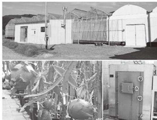
写真9 (株)コスモ精機のハウス加温用エコボイラ
