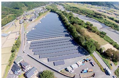
伊予鉄道(株) (990kW) 「いよてつ東温ソーラー発電所」
